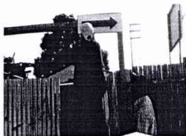
Implementación de señalizaciones de tránsito vehicular
